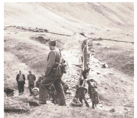
Verlegung des Stromkabels
